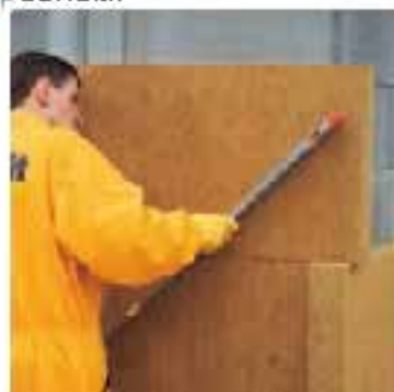
Рис. Контроль установки плит утеплителя
